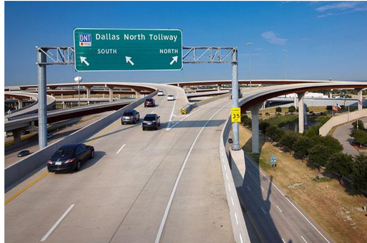
Nový dynamický systém placení mýtného v Texasu (USA)
